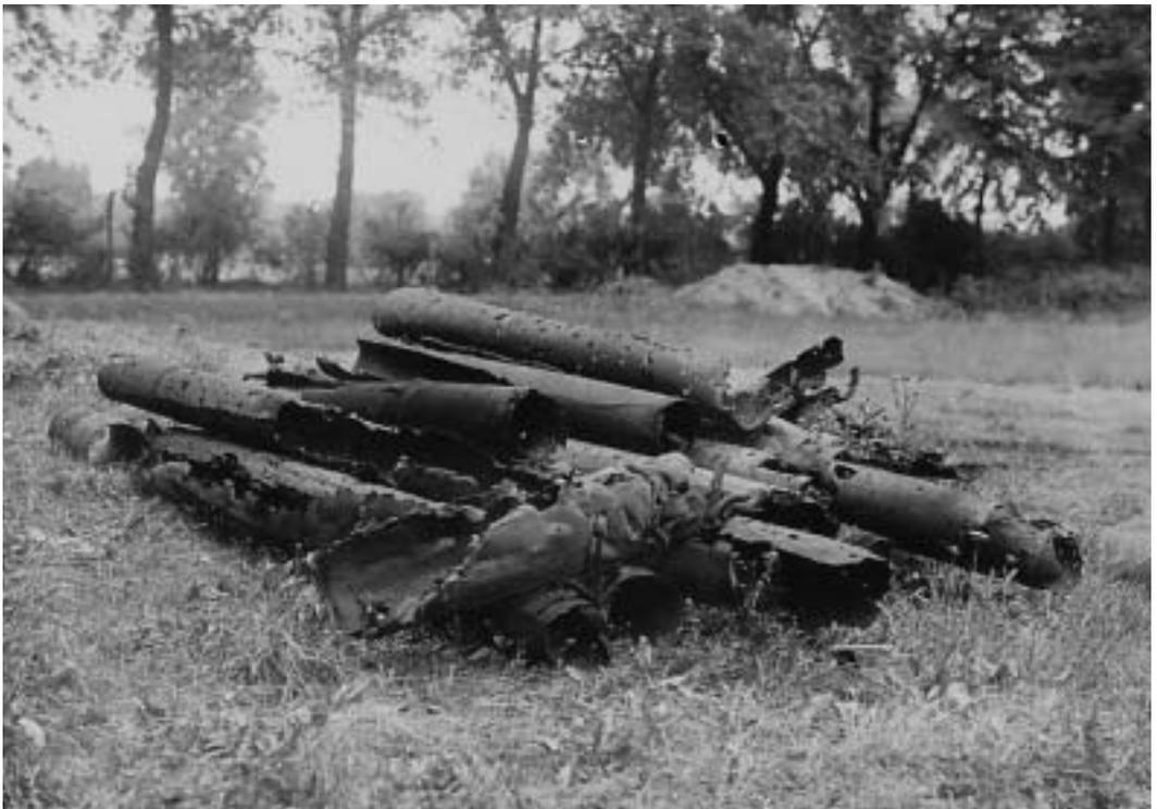
Abb. 83: Reste der korrodierten eisernen Hilfsverrohrung, 1936.
